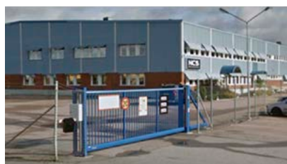
Fastighetsbeteckning: Spinnaren 4 & 6 Region: Köping Uthyrningsbar yta: 8 903 kvm
