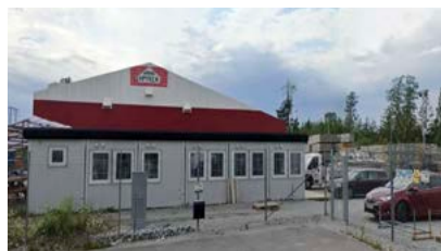
Fastighetsbeteckning: Märsta 21:72 Region: Stockholm Uthyrningsbar yta: 1 125 kvm
